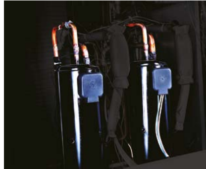
Múltiples compresores Inverter de gran potencia (más de 14 HP).
