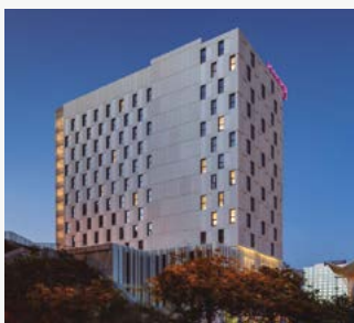
Hotel Moxy Oriente. Hotel. Lisboa, Portugal. PACi, VRF y control.
