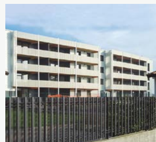
Crosslight House. Edificio residencial. Mulazzano, Italia. PACi y nanoe™ X.
